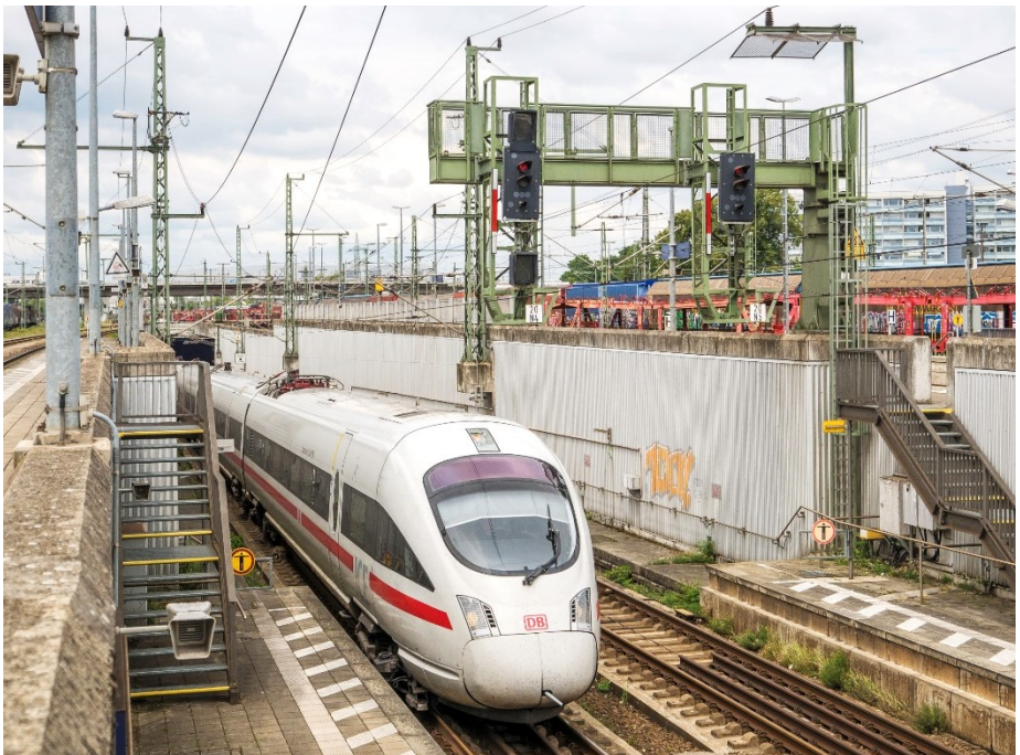
Am 25.7.25 verließ ein ICE nach München den Audi-Tunnel und erreichte die tief liegenden Bahnsteige im Bahnhof Ingolstadt Nord.
