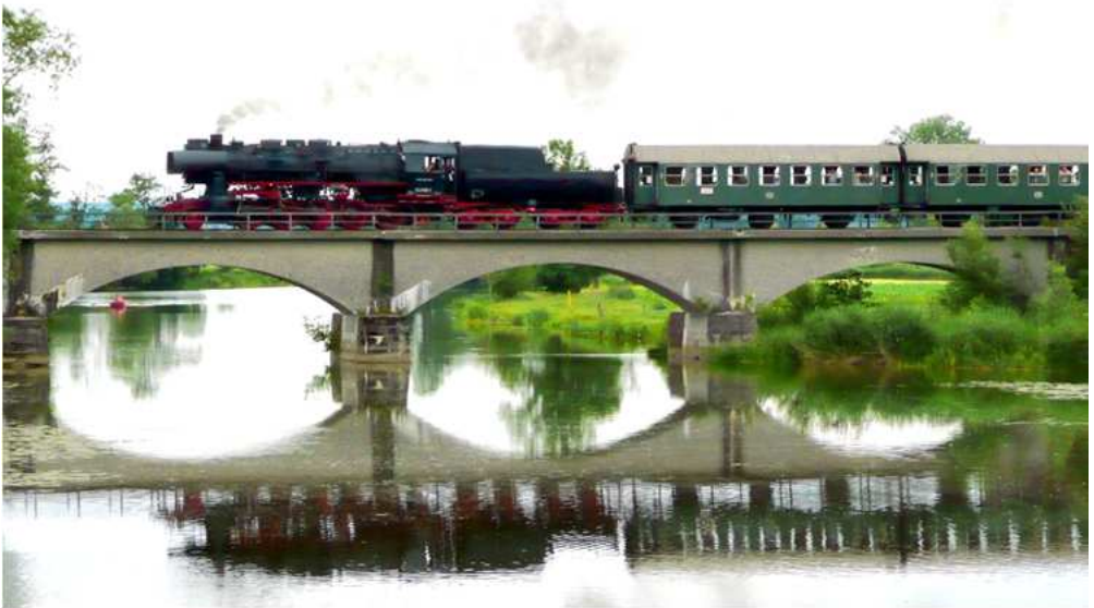
Die BEM-Lok 52 8195 dampfte am 14.Juni 2009 über die Wörnitzbrücke bei Oettingen mit ihrem Sonderzug nach Nördlingen. (Bild von J.Schäfer)
